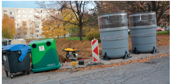
Mesto osadilo 140 polopodzemných kontajnerov na komunálny odpad s GPS snímačmi, ktoré oznamujú naplnenosť kontajneru.
